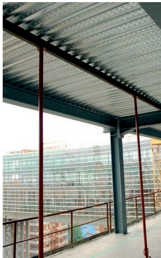
Imagen apuntalamiento provisional
