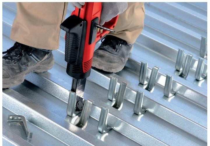
Conectores fijados mecánicamente
