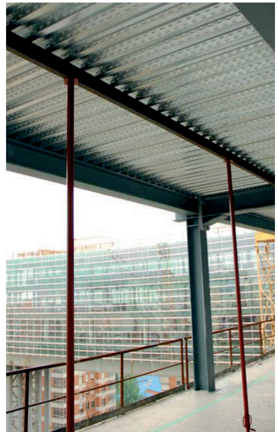
Imagen apuntalamiento provisional
